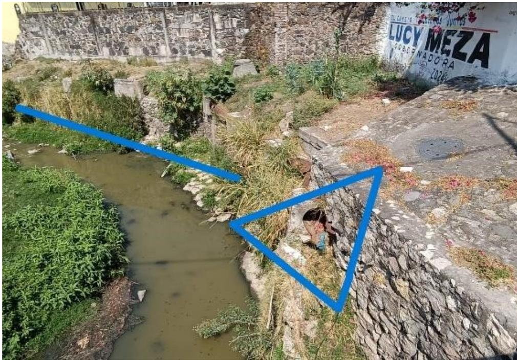
Colectores colapsados en la Barranca Apanquetzalco
